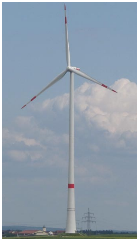
In der Nähe von Wohngebäuden, wie hier bei Berchting, mag heute niemand gerne ein Windkraft haben.
