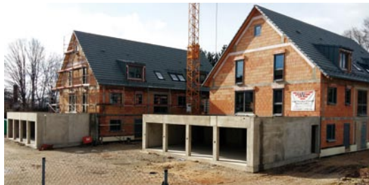
Wo jetzt der Rohbau neuer Wohnhäuser steht, befand sich vor wenigen Jahren noch ein Biotop. Das hat die Gemeinde einfach plattgemacht. (Foto: W.Seemann)
