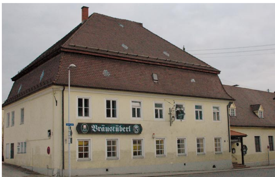
Das Bräustüberl, so wie man es kennt, wird es bald nicht mehr geben. Hier werden Geschäfte und Wohnungen entstehen. Foto: Seemann
